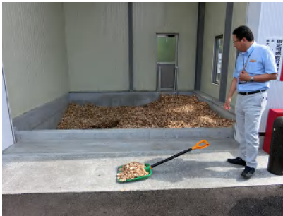
給湯ボイラー設備の木質チップボイラー施設
