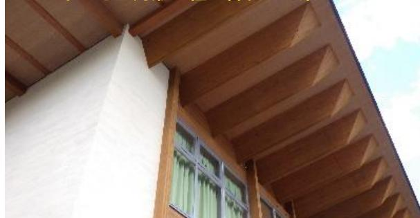
★CLTとはCross Laminated Timber (JASでは直交集成板)の略称で、ひき板(ラミナ)を並べた後、繊維方向が直交するように積層接着した木質系材料です。
